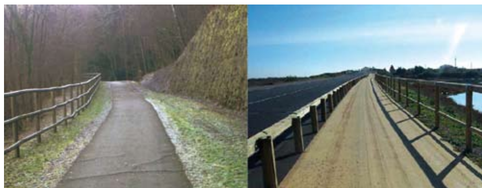
Imatge 16.- Barreres de contenció de fusta en vies ciclistes
