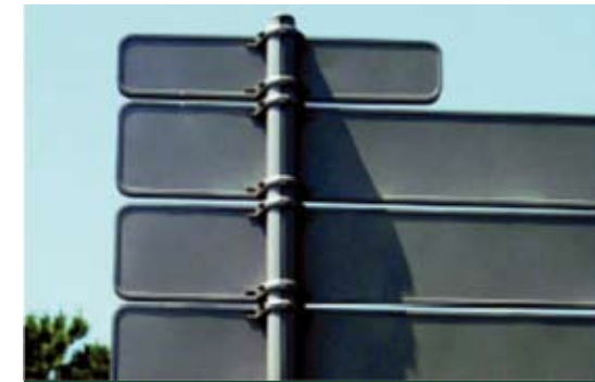
Imatge 12.- Perfil extrudit al voltant del rètol
